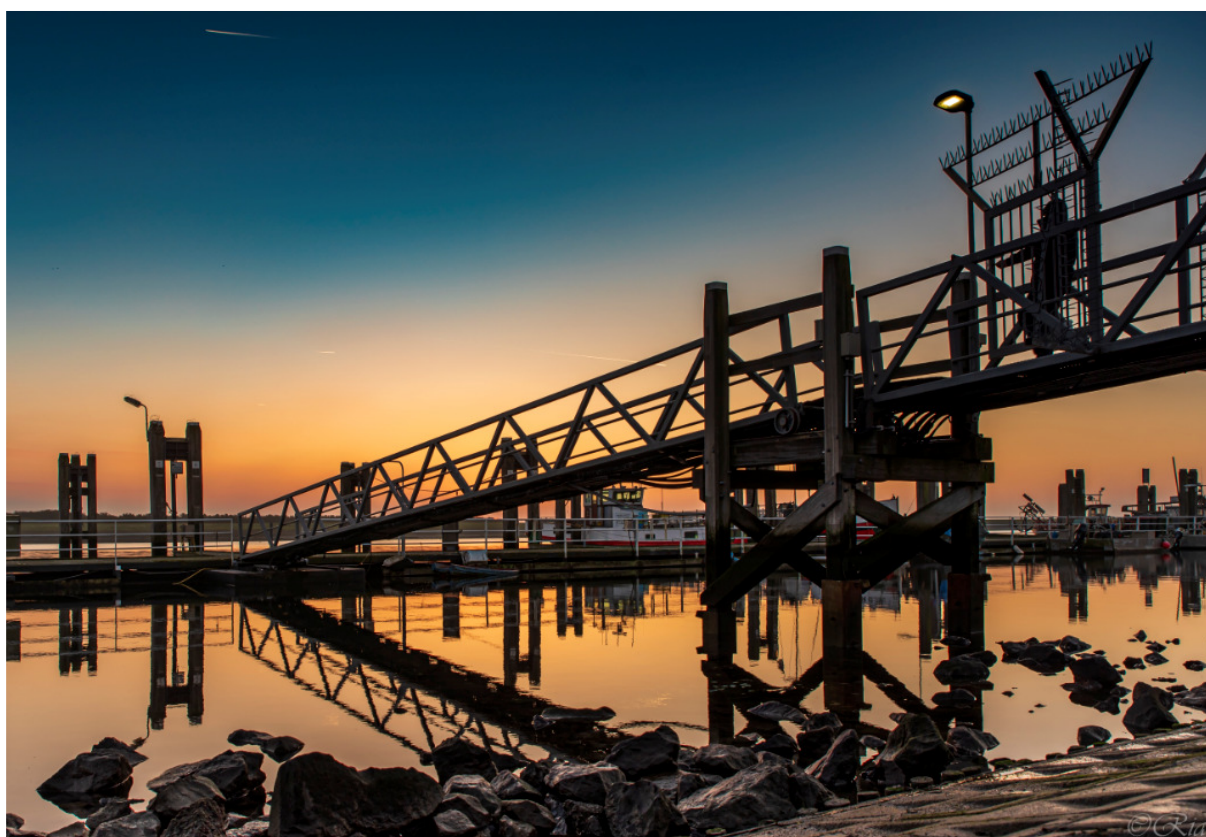
Bergse Diepsluis tijdens zonsondergang
